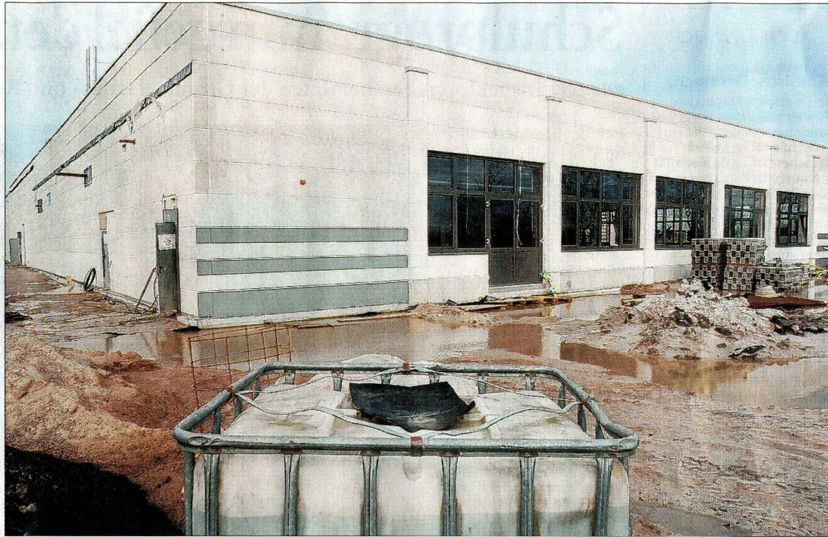
Der Neubau der Ostfriesischen Beschäftigungs- und Wohnstätten GmbH an der Herderstraße kommt zügig voran. Er soll Ende dieses Jahres fertig sein.
